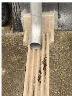
Regnvandet ledes fra tagrenden via vandlederen og væk fra soklen.
