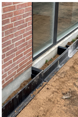
Stenseng i opbygningen og til slut med sten
